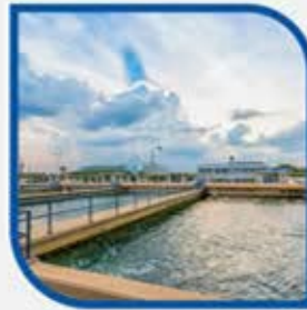
Effluent Treatment Plant (ETP)
